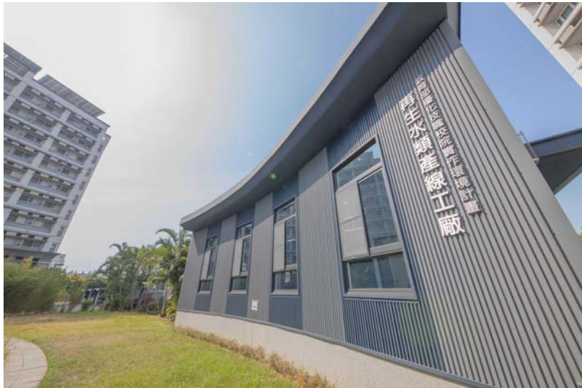
▲ 嘉藥設有國家級再生水類產線及完整配線下水道技能訓練基地
