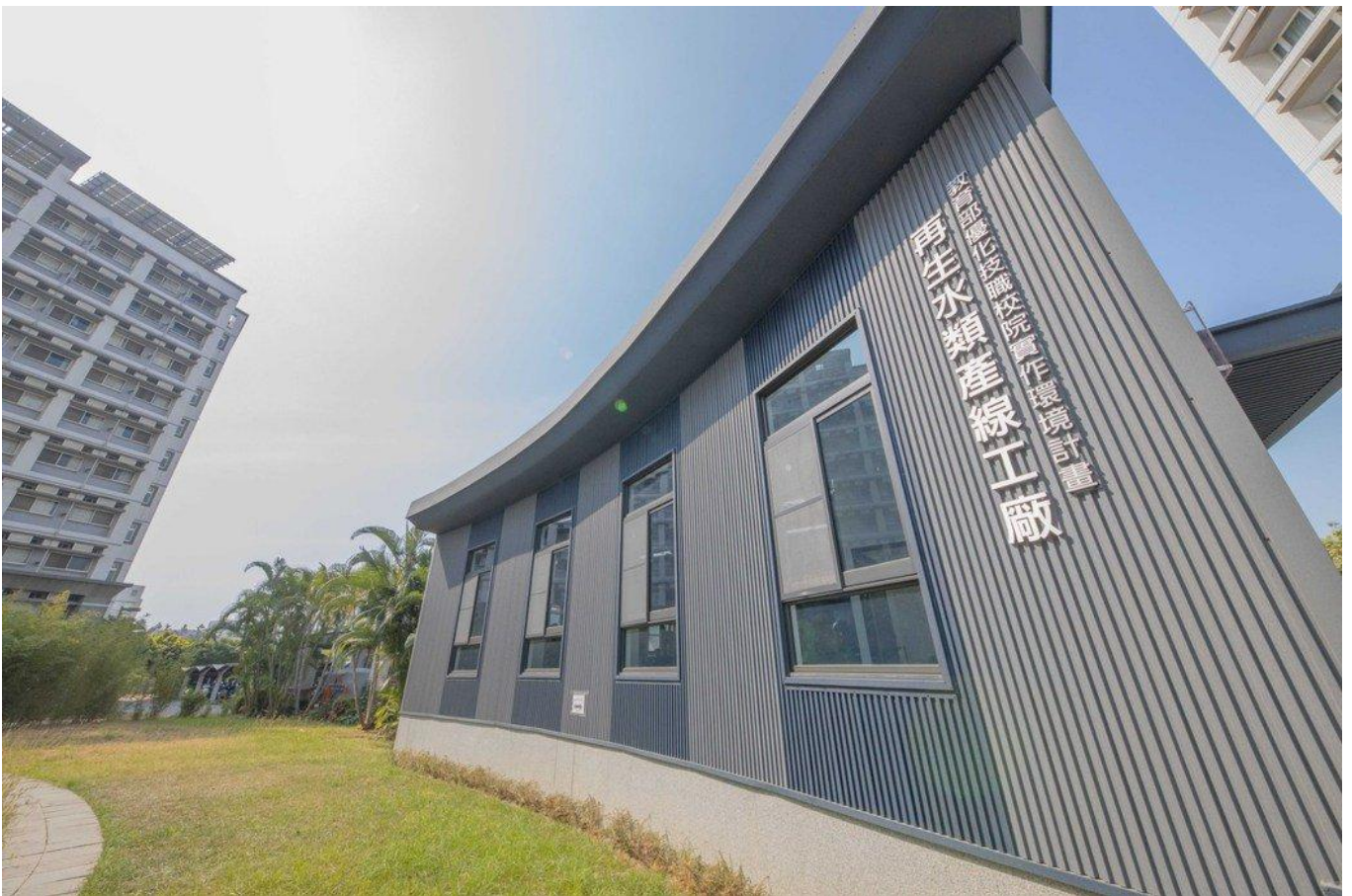
嘉藥設有國家級再生水類產線及完整配線下水道技能訓練基地。嘉藥／提供
