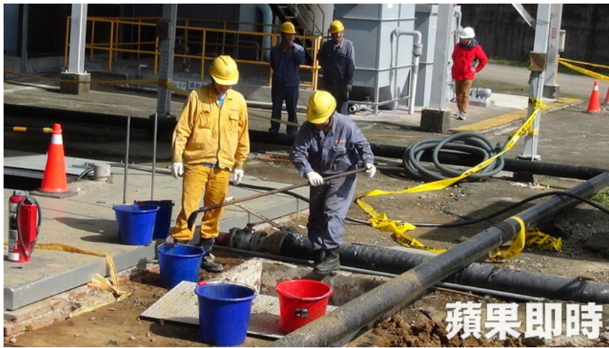
廠方人員上午開挖地點進行除油作業。吳傑沐攝
