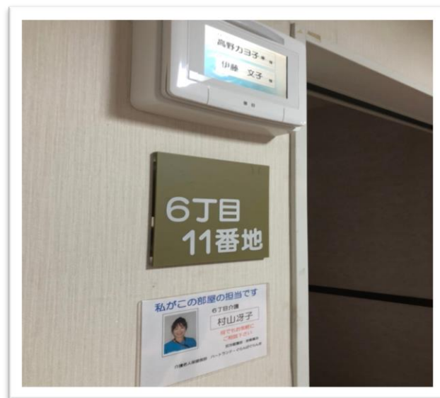
▲上方之機器為資訊顯示器，結合患者姓名，以及救護鈴響起，LED 燈的閃爍可告知前來的負責人
