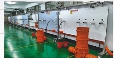
↑ 下水道用戶排水設備配管實習設備
