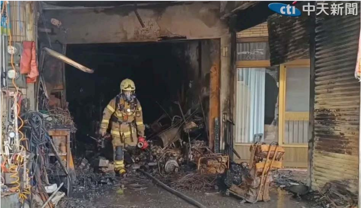
透天厝內天井貫通，火煙勢必迅速挾著高熱往上竄，若起火點在一樓，一、三樓會迅速陷入火海，再燒至二樓。(圖 / 中天資料照)
