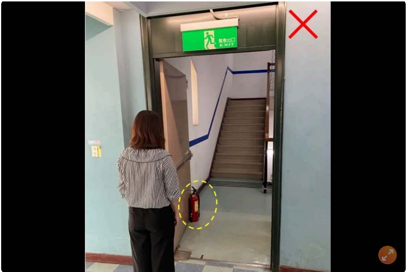
大型建物火災時常見「煙囪效應」，平時應該要關樓梯間逃生門。資料照
